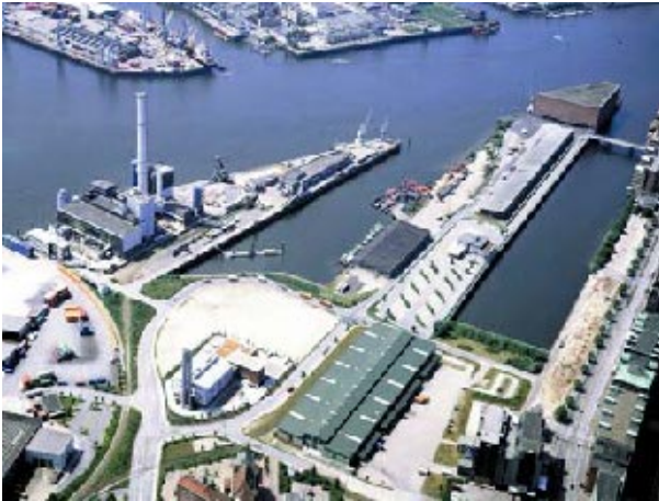
Heizkraftwerk im Hamburger Hafen: Bei lebens- und verteidigungswichtigen Einrichtungen ist der vorbeugende personelle Sabotageschutz wichtig.
